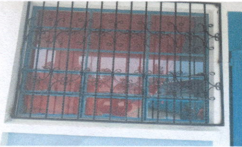
Foto 5: Sustitución de balcones.
