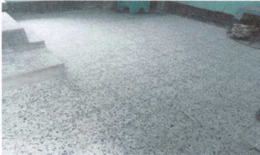
Foto 3: Sustitución de piso de torta a piso de granito.
