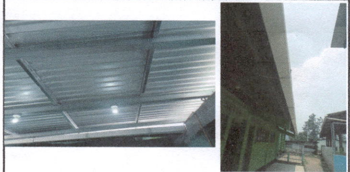
Foto 4: sustitucion de estructura de madera por metal , sustitución de lamina toquelada aluzinc calibre 26 y Sustitucion de canales.
