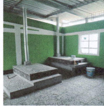
Foto 2: Sustitución de plancha de metal de tres ornillas de chimenea de metal.
