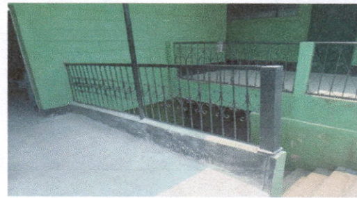
Foto 6: Sustitucion de barandas.
