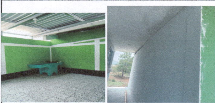
Foto1: Pintura en interiores, sustitución de pila y repello de pared de cocina.
